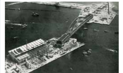
ポートターミナルと神戸大橋
